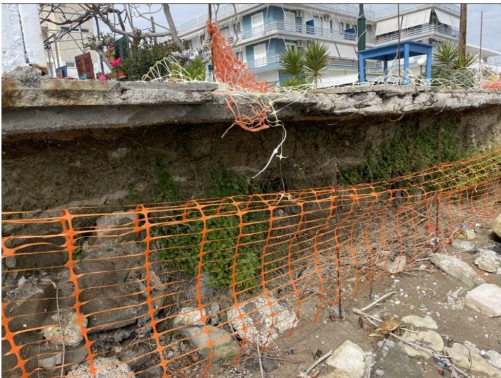
(φωτ.4) υποσκαφή της θεμελίωσης του τοιχίου αντιστήριξης
