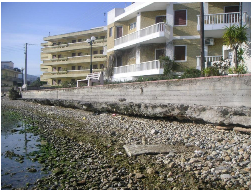
(φωτ.10) υποσκαφή της θεμελίωσης του τοιχίου αντιστήριξης
