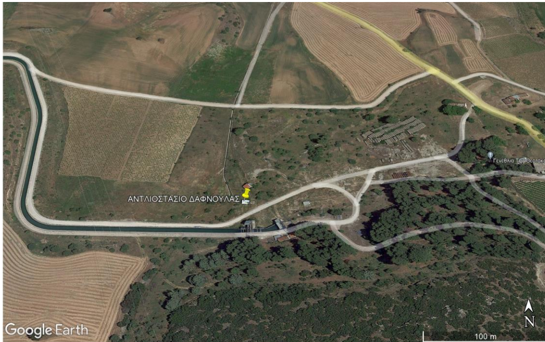
Αντλιοστάσιο αδιύλιστου νερού τη θέση «ΔΑΦΝΟΥΛΑ»
