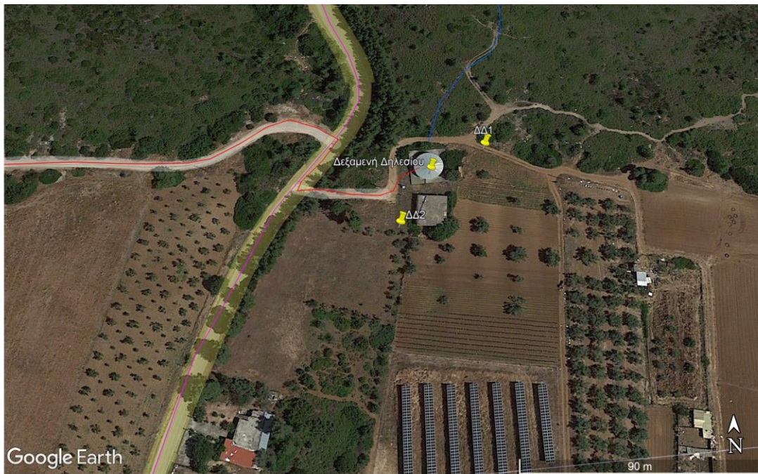
Δεξαμενή διυλισμένου νερού Δηλεσίου
