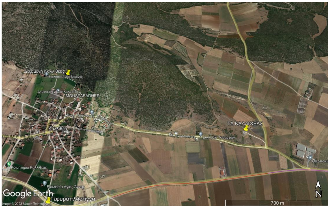
Τ/Δ Καλλιθέας - Δεξαμενή διυλισμένου νερού Καλλιθέας
