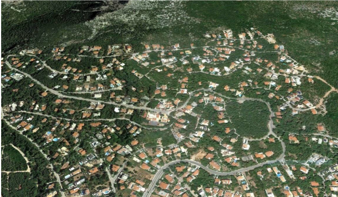
Εικόνα 10.2. Δομημένη περιοχή που κατά το παρελθόν έχει αναπτυχθεί εντός δάσους ή δασικής έκτασης και τα κτίσματα που την συγκροτούν έχουν μεγάλη εγγύτητα με καύσιμα δασικής προέλευσης.
